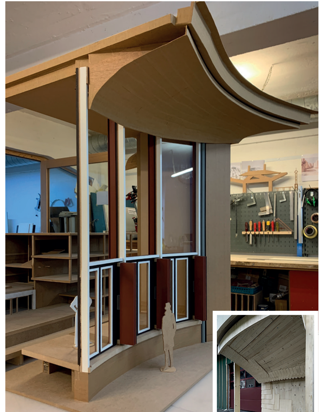
Modell Wandaufbau mit Resonanzkammern (oben)
